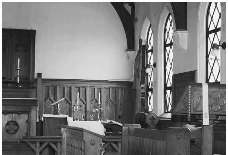
崩落した聖堂奥壁
